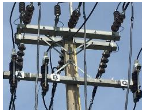
รูปที่ 5 แสดงการติดตั้ง Guard Cover Disconnect switch , Guard Cover Drop Out Fuse
