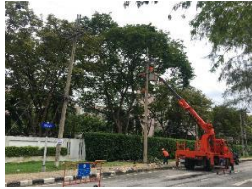
รูปที่ 13 แสดงการทำงานติดตั้งอุปกรณ์ตัดต่อกระแสไฟฟ้าแรงสูง Load Break Switch SF6 Gas
