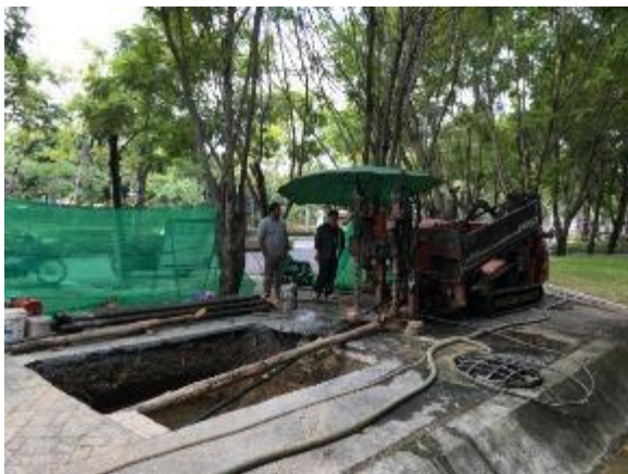
รูปที่ 11 แสดงการเดินท่อลอดชนิด Horizontal Directional Drilling (HDD.) ท่อ HDPE PE.80 PN.10 Class 1. ขนาด 140 mm.
