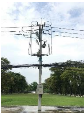
รูปที่ 12 แสดงการทำงานติดตั้งอุปกรณ์ตัดต่อกระแสไฟฟ้าแรงสูง Load Break Switch SF6 Gas
