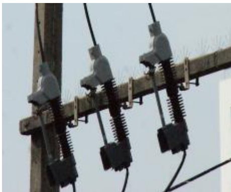
รูปที่ 5 แสดงการติดตั้ง Guard Cover Disconnect switch , Guard Cover Drop Out Fuse
