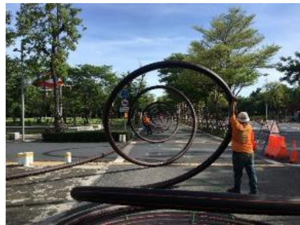
รูปที่ 11 แสดงการเดินท่อลอดชนิด Horizontal Directional Drilling (HDD.) ท่อ HDPE PE.80 PN.10 Class 1. ขนาด 140 mm.
