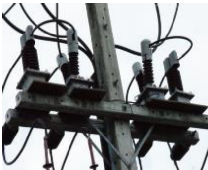
รูปที่ 6 แสดงการติดตั้ง Guard Cover อุปกรณ์ประกอบเครื่องวัดมิเตอร์ไฟฟ้าแรงสูง CT VT
