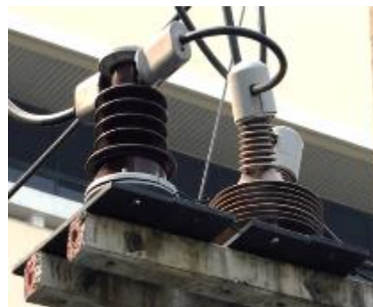
รูปที่ 6 แสดงการติดตั้ง Guard Cover อุปกรณ์ประกอบเครื่องวัดมิเตอร์ไฟฟ้าแรงสูง CT VT
