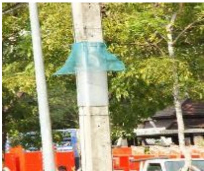
รูปที่ 7 แสดงการติดตั้ง Guard Cover บุษชิง หม้อแปลงไฟฟ้า
