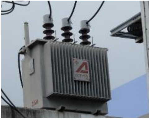
รูปที่ 7 แสดงการติดตั้ง Guard Cover บุษชิง หม้อแปลงไฟฟ้า
