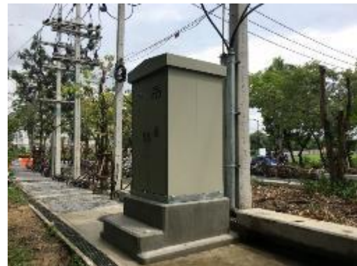
รูปที่ 14 แสดงการทำงานติดตั้งอุปกรณ์ตัดต่อกระแสไฟฟ้าแรงสูง Ring Main Unit 24 kv 1 in 1 Out
