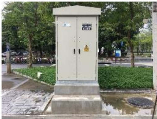
รูปที่ 14 แสดงการทำงานติดตั้งอุปกรณ์ตัดต่อกระแสไฟฟ้าแรงสูง Ring Main Unit 24 kv 1 in 1 Out
