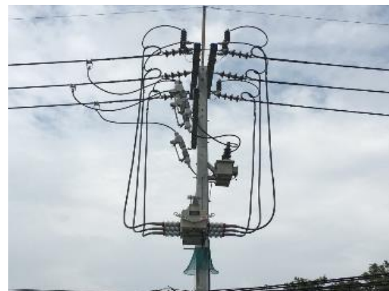
รูปที่ 12 แสดงการทำงานติดตั้งอุปกรณ์ตัดต่อกระแสไฟฟ้าแรงสูง Load Break Switch SF6 Gas
