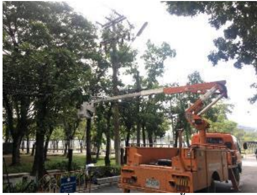
รูปที่ 13 แสดงการทำงานติดตั้งอุปกรณ์ตัดต่อกระแสไฟฟ้าแรงสูง Load Break Switch SF6 Gas
