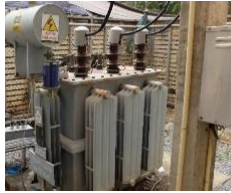
รูปที่ 7 แสดงการติดตั้ง Guard Cover บุษชิง หม้อแปลงไฟฟ้า
